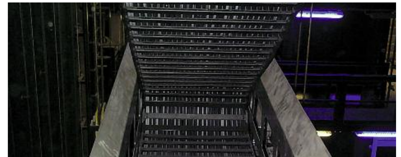
Koaxleitung und andere chainflex®-Leitungen in der Bühnentechnik. e-kette®: System E4/4
