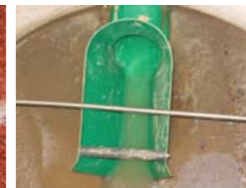
Messschachtrinne von DN 100 ( Q_{max} 5,7 l/s) bis DN 300 ( Q_{max} 94,4 l/s) erhältlich.
