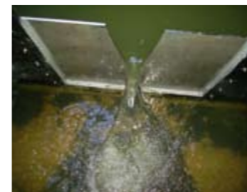
V-Wehr Die Wehre werden von uns berechnet. Verschiedene Formen möglich.
