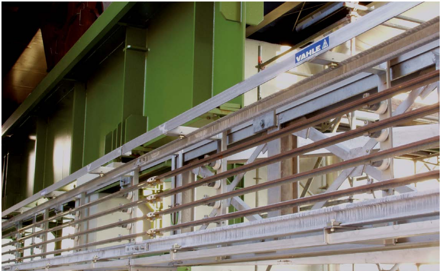
Kokereibetrieb (System 3-polig + PE mit geführtem Stromabnehmerwagen) (Wagen nicht im Bild).
