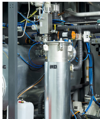
Contrôle et séchage des filtres
