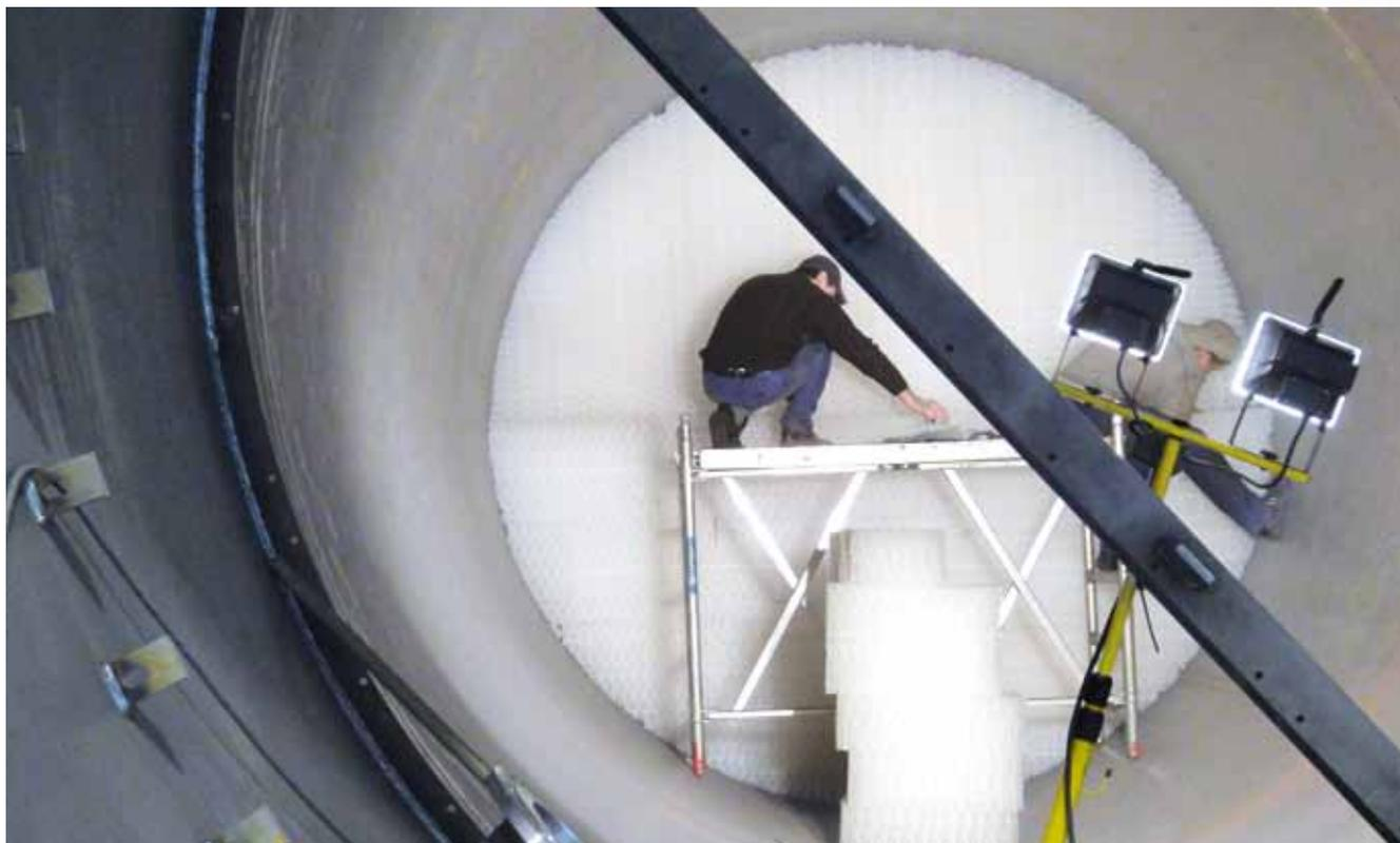
*Die komplette Bestückung der liegenden Kolonne bereits beim Kolonnenhersteller bringt Kostenvorteile beim Transport und der Montage auf der Baustelle.*
