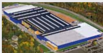
Hörmann KG Eckelhausen, Allemagne
