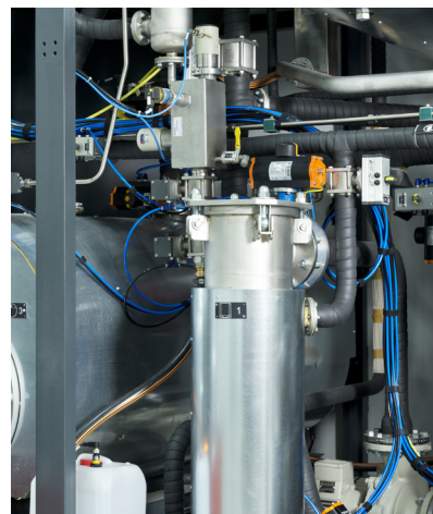
Contrôle et séchage des filtres
