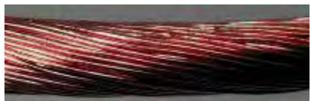
Eine Nahaufnahme des vollständig intakten Kupferleiters. Die über die gesamte Länge durchgeführte Untersuchung zeigt, dass der Leiter noch völlig intakt ist und keine Einzeldrahtbrüche aufweist.
