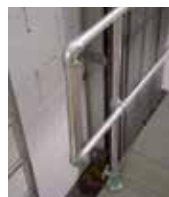
Garde-corps continu et fermé pour éviter les accidents
