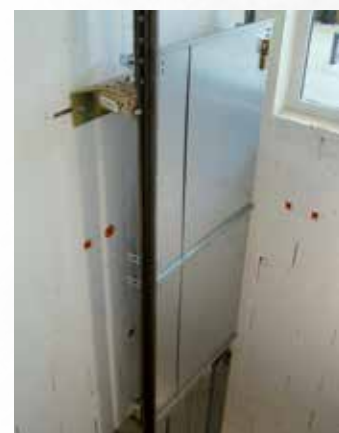
Détails: tôles en acier galvanisées, 1,5 mm
