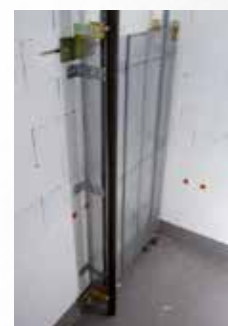
Détails: Tôles perforées galvanisées avec une ouverture de maille de 8x8
