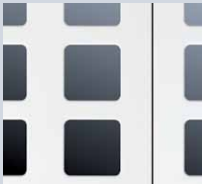
Ventilatie-doorlaat: ca. 25 % van de deuropervlakte
