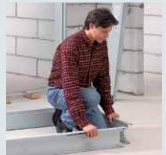
Steekkozijnen in handige verpakking voor een eenvoudige doe-het-zelfmontage
