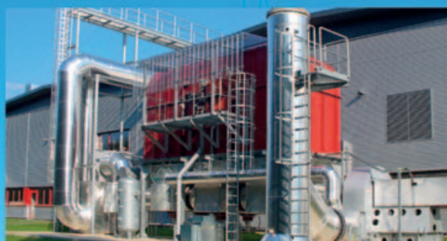
Tubenproduktion: Spezielle 3-Kammer-Anlage TRA 20 000 für 7 Druck- und Lackierlinien für Blechtuben.
