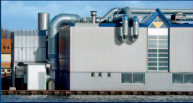
Tiefdruck: TRA 2-Turm 55 000 zur Entsorgung der Abluft von 3 Tiefdruckmaschinen. KBA führte in diesem Projekt auch die Druckmaschinenoptimierung zur Reduktion der Abluftmenge durch.
