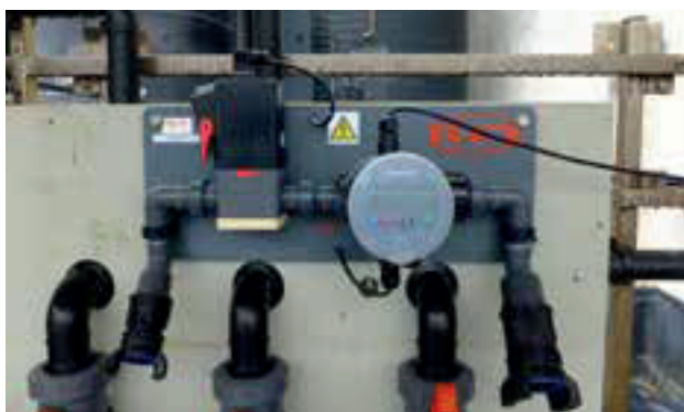
FMC 100 avec amplificateur de commutation FSV 100 monté sur une conduite pour un remplissage semi-automatique.
