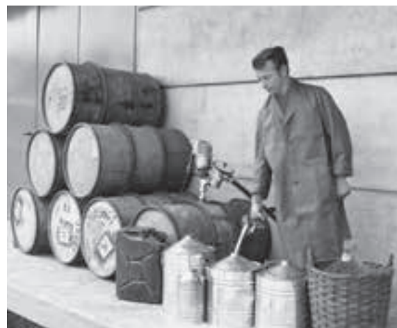
Remplissage manuel avec une pompe vide-fûts et un compteurs de débit à piston rotatif en 1960.
