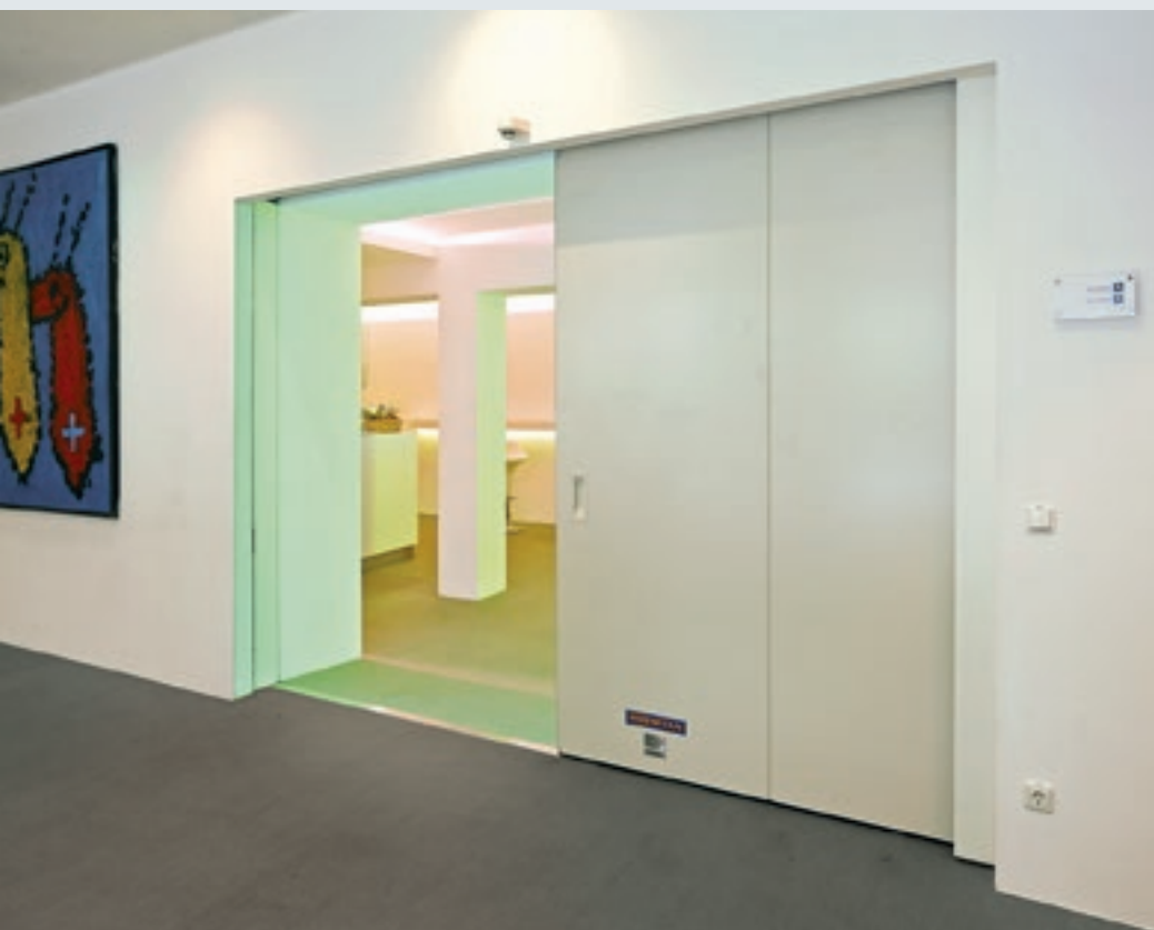
Nischenklappen integrieren die Schiebetore unauffällig in öffentlichen Bereichen. Weitere Informationen finden Sie auf Seite 19.
