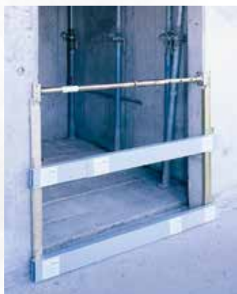
Variante 1: Protection partielle d'entrée de gaine d'ascenseur
