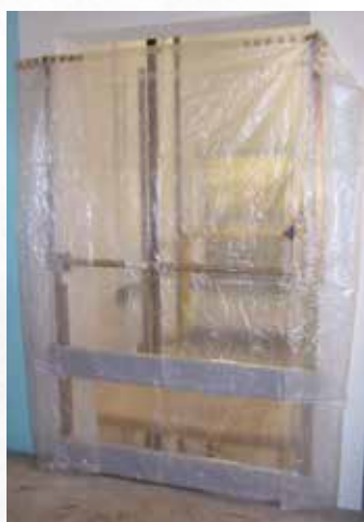
Variante 2: Protection étendue d'entrée de gaine d'ascenseur
