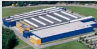
Hörmann KG Eckelhausen, Allemagne
