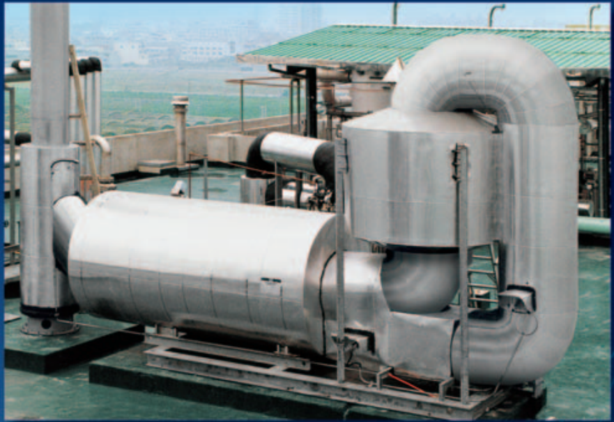
Baugrößen bis 6 000 m 3 N /h werden auf Grundrahmen vormontiert ausgeliefert (siehe Schnittbild); größere Anlagen werden vor Ort montiert.
