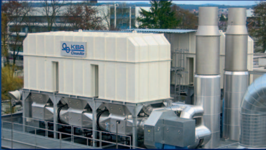
Geruchseliminierung Aromaindustrie: Zwei parallel betriebene TRA in Edelstahlaustrführung mit speziellem Online-Burn-Out zur Reinigung von jeweils 28 000 m 3 N /h geruchsintensiver Abluft aus der Aromaherstellung.
