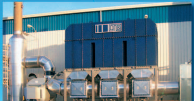
Baustoffbeschichtung: TRA 26 000 mit Warmwasser-Wärmtauscher zur Entsorgung der Abluft aus der Bitumenbeschichtung von Baustoffen.
