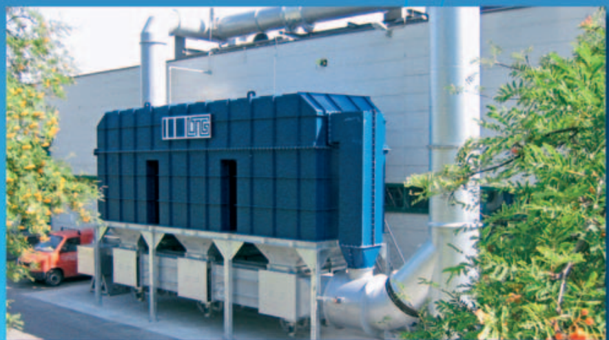
Automotive: TRA in 3-Turm-Bauweise zur Reinigung von 30 000 m 3 N /h Abluft aus zahlreichen Absaugquellen bei der Herstellung von Motorendichtungen. Mit heißem Bypass sowie XtraComb® -Keramikspeicher, XtraBalance® und XtraControl™ -Steuerung zur optimalen internen Wärmerückgewinnung und niedrigstem Energieverbrauch.
