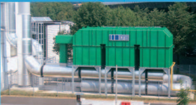
Tiefdruck, Bereich Zigarettenverpackungen: TRA 45 000 mit heißem Bypass zur Reinigung der Abluft aus 2 Tiefdruckmaschinen.
