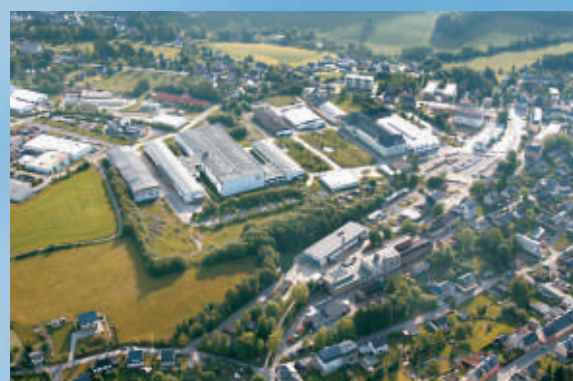
Elektromotorenwerk Grünhain heute Elektromotorenwerk Grünhain today
