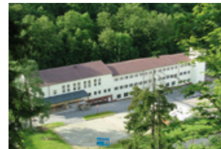
Werk 3 – Unterweißbach Transformatorenbau
