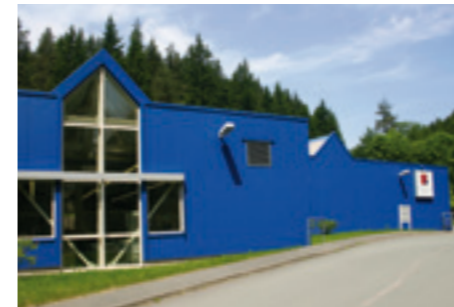
Werk 2 – Mellenbach Elektronikfertigung
