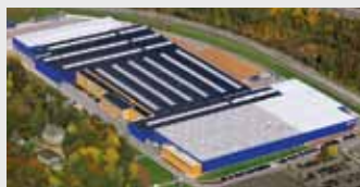
Hörmann KG Eckelhausen, Allemagne
