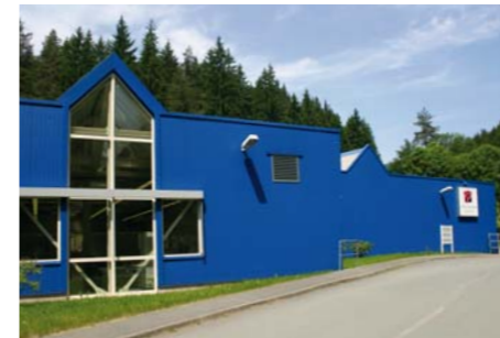
Werk 2 – Mellenbach Elektronikfertigung
