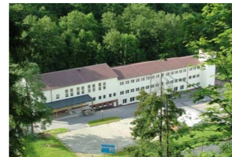
Werk 3 – Unterweißbach Transformatorenbau
