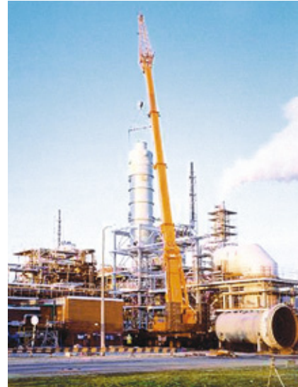
Montage eines Rauchgaswäschers
