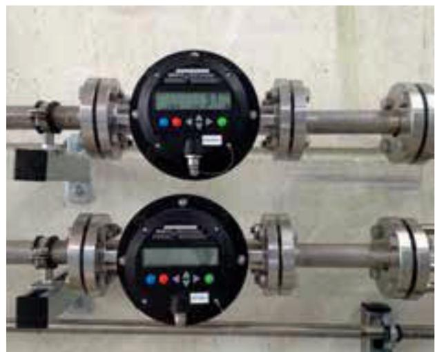
FMO 150 mit Flanschanschluss eingebaut in einer Rohrleitung.
