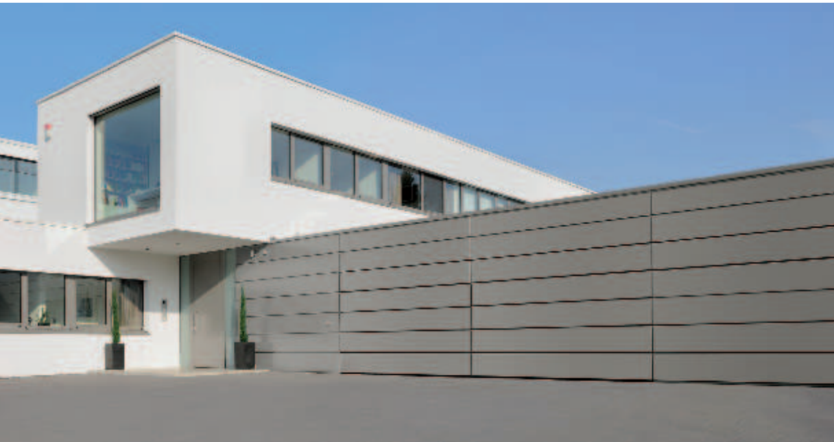
Bauseitige Beplankung mit Aluminium-Verbundplatten
