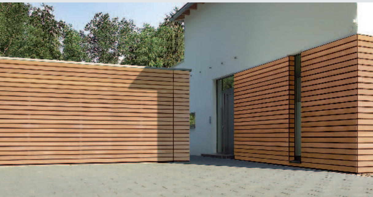
Bauseitige Beplankung mit Holzpaneelen
