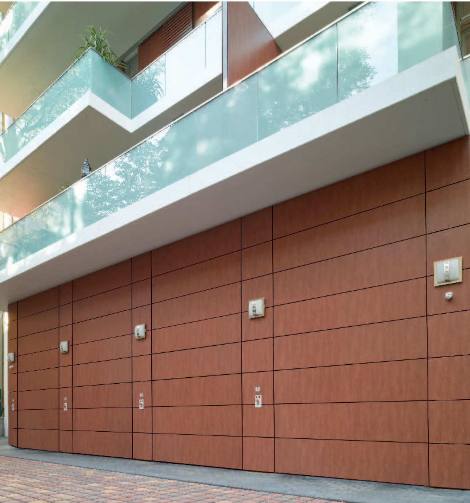
Bauseitige Beplankung mit Schichtpress-Holzplatten
