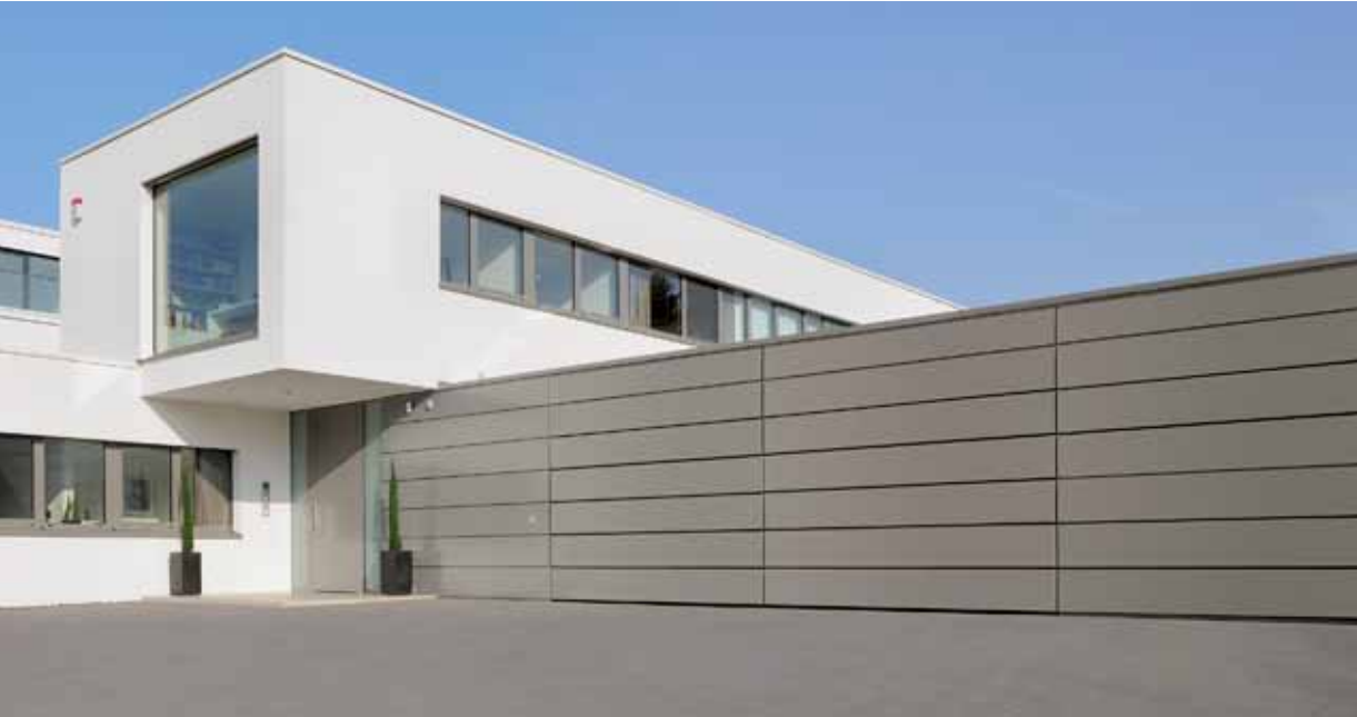
Revestimiento en la obra con placas aglomeradas de aluminio
