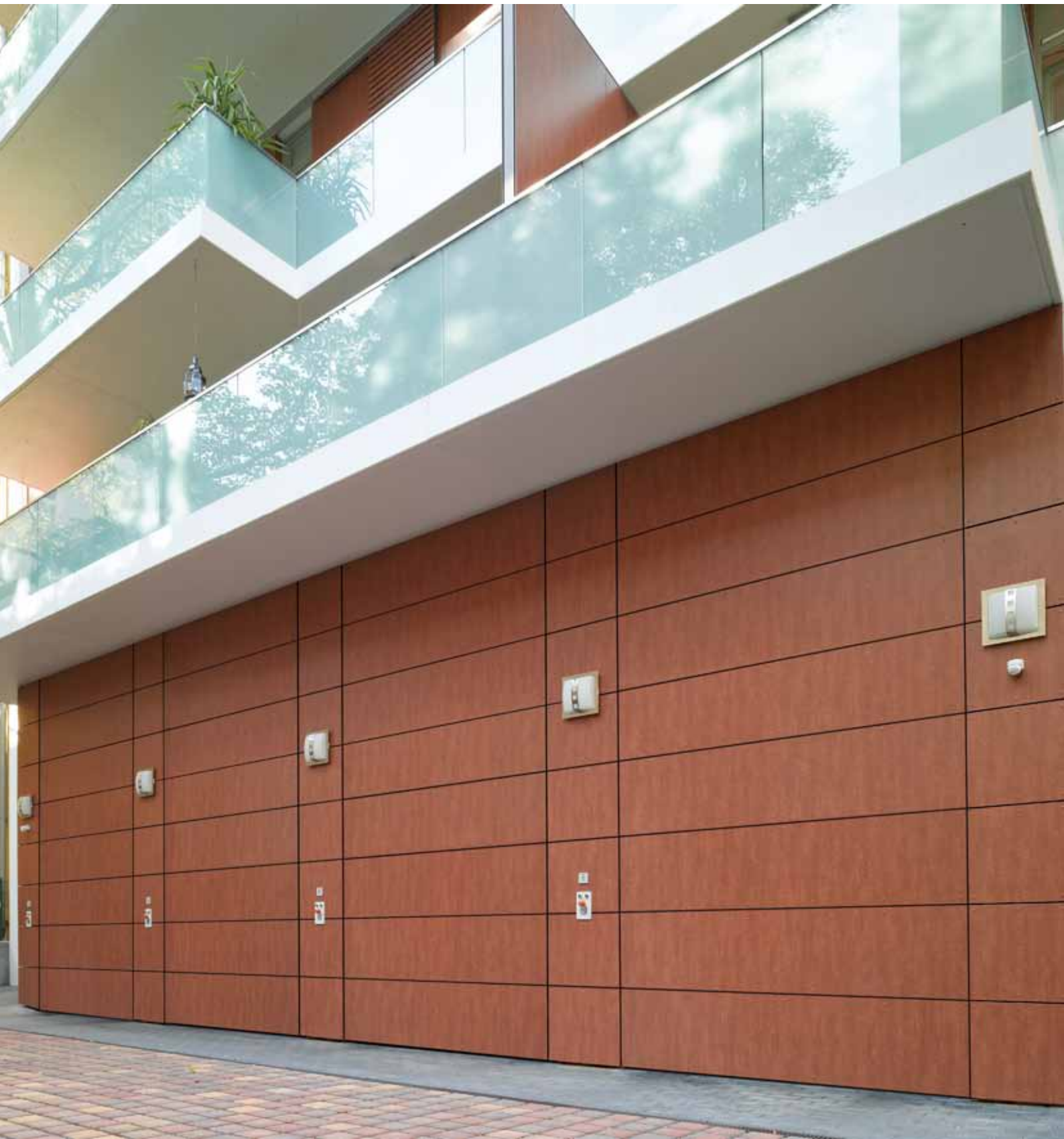
Revestimiento en la obra con placas de madera aglomerada
