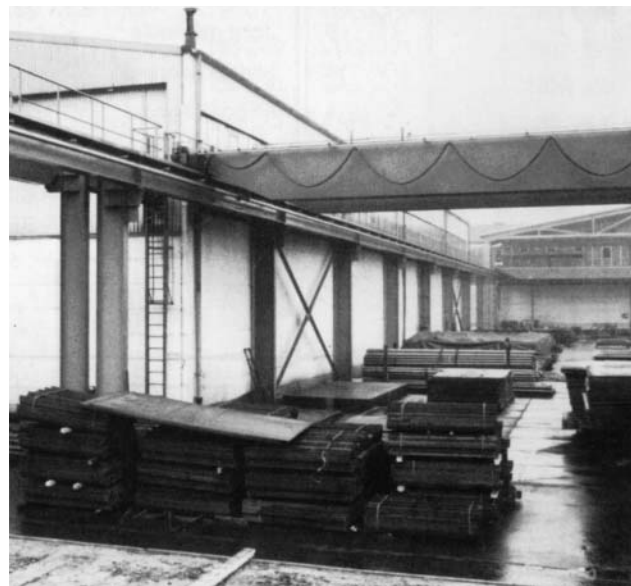
LSV para Puente-Grúa en un almacén de hierros
