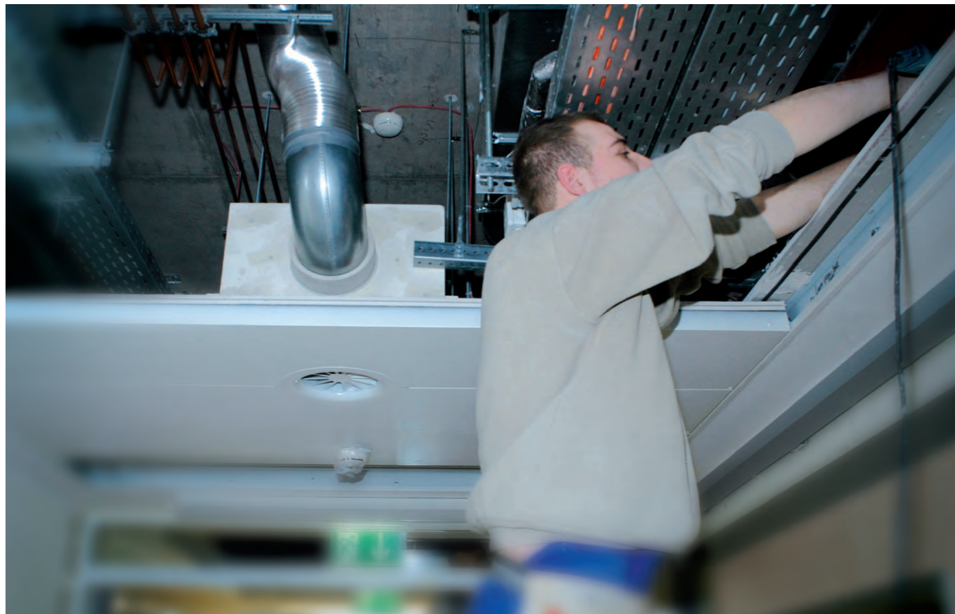
Lüftungsanschluss in F30
