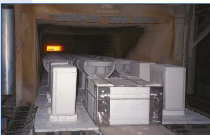
Kiln Tracker System im Rollenofen für Sanitärkeramik
