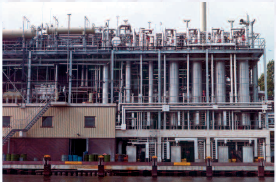
Mehrstufige Fallfilmverdampferanlage für Miscella-Destillation
