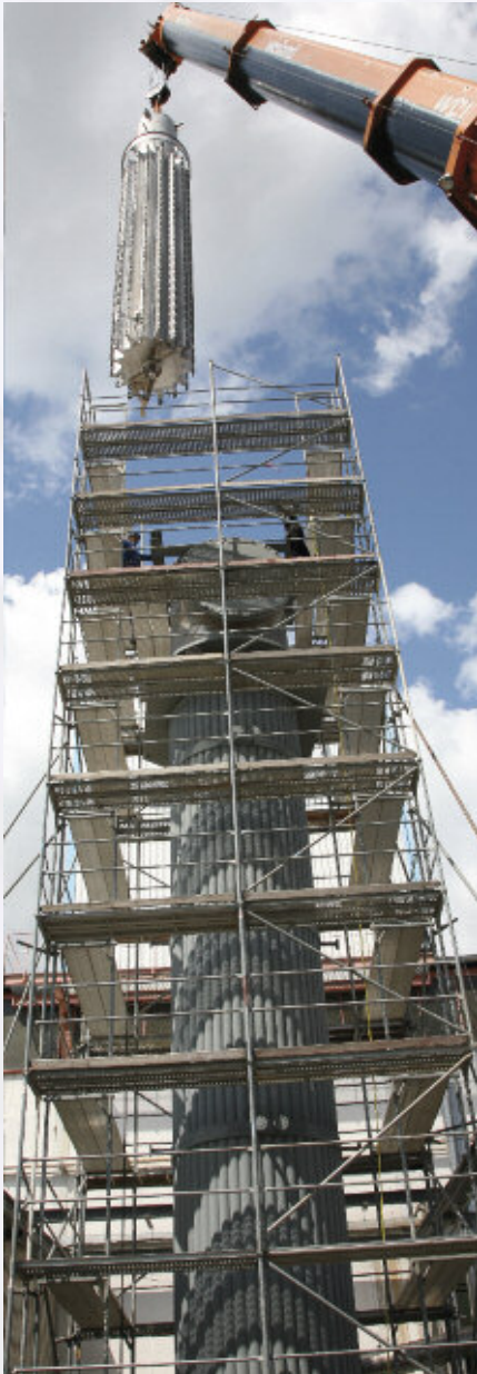
CP-Trockner bei der Montage
