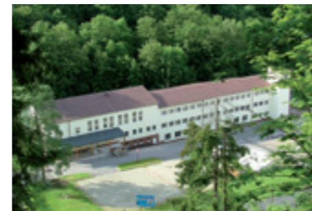
Werk 3 – Unterweißbach Transformatorbau
