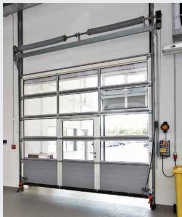
På insidan av lackerade portar levereras också portbladsförstärkningar** och sektionernas ändbeslag alltid i gråvitt, RAL 9002. Hos portar med gångdörr består gångdörrsramen på insidan av aluminiumprofiler i E6 / C0 (tidigare E6 / EV 1).
