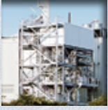
Verbrennungsanlagen für die Entsorgung von Abluft, Abgasen und flüssigen Reststoffen
