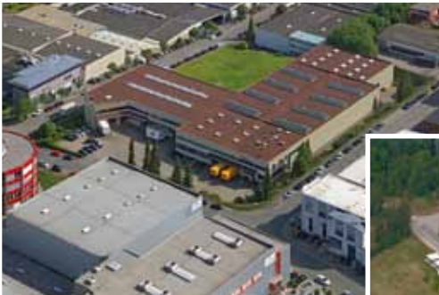
Weichselstraße 9-11, 58256 Ennepetal Logistikzentrum
