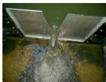
V-přepad Tyto přepady jsou propočítány u nás.
