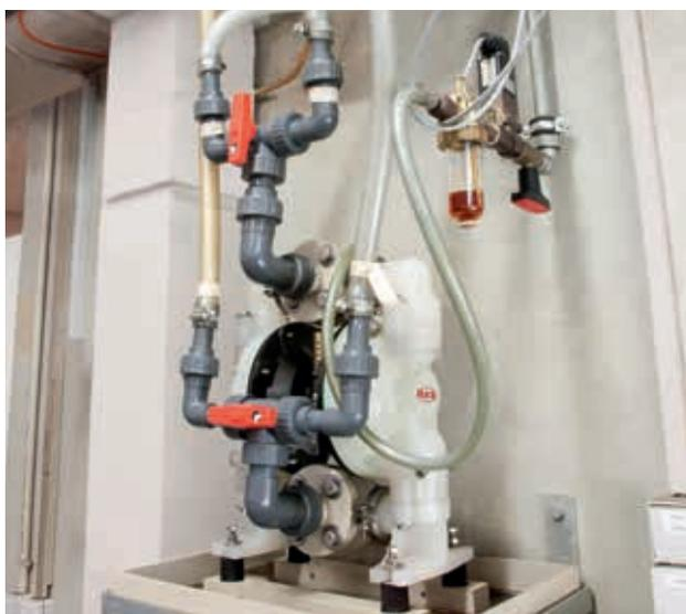
FDM : Transfert de nickel chimique pour le mélange d'un bassin de galvanisation.
