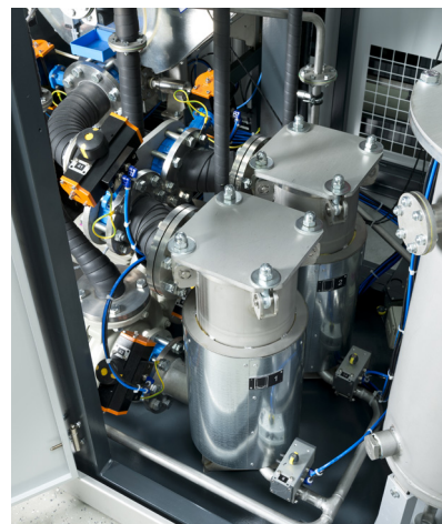
Contrôle et séchage des filtres
