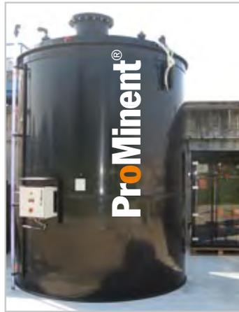
Serbatoio di ferro cloro solfato con skid di dosaggio per rimozione fosforo da impianto di depurazione
