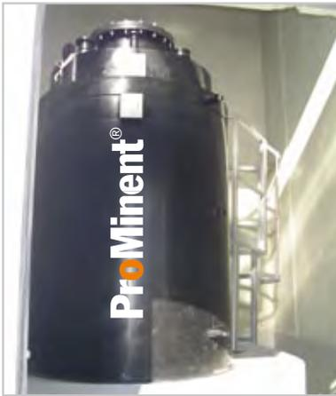
Serbatoio di stoccaggio acido cloridrico 30-33% e clorito di sodio 25%, 7 m<sup>3</sup>, impianto di potabilizzazione per produzione biossido di cloro
