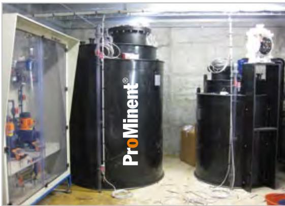
Serbatoi di stoccaggio per la preparazione di soluzioni di acido cloridrico al 33% da 1 m<sup>3</sup> e 2,5m<sup>3</sup> e Skid dosaggio con pompe Sigma
