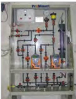
Dosaggio flocculante e acido cloridrico con pompe delta<sup>®</sup> presso impianto di trattamento acqua di fiume
