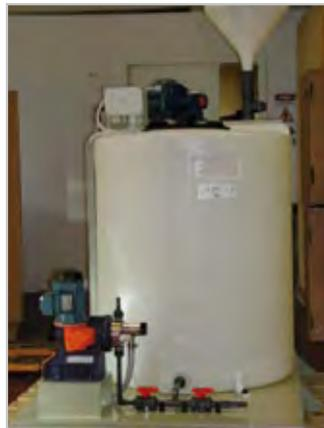
Skid di preparazione, stoccaggio e dosaggio polielettrolita in polvere
