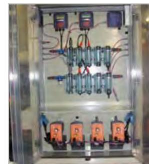
Skid di misura ed analisi multiparametrico con dosaggio chemicals e copertura anti schizzo
