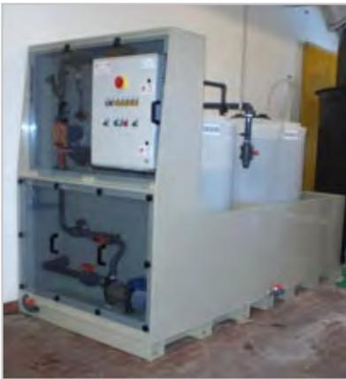
Skid completo dosaggio + stoccaggio per controllo e regolazione pH per acqua di scarico
