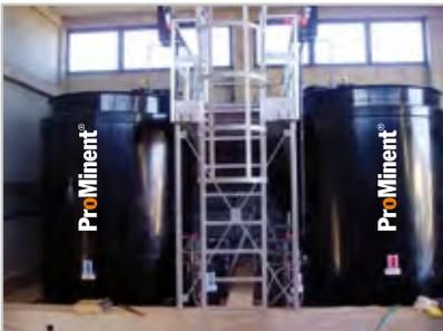
Serbatoi in PEHD da 5 m<sup>3</sup> antisismici completi di camicia di contenimento, scaletta e passerella per acido cloridrico al 33% e clorito di sodio al 25%
