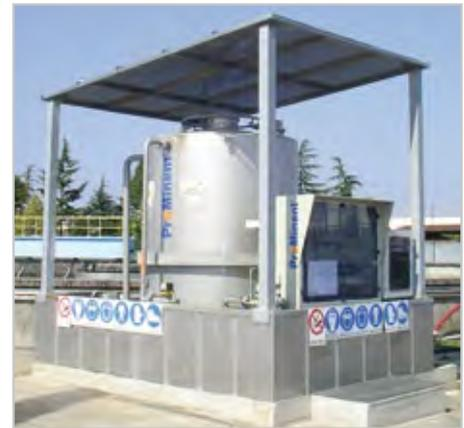
Sistema completo di stoccaggio e dosaggio con messa in sicurezza di acido peracetico per impianto di depurazione completamente in AISI 316
