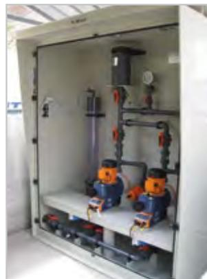
Dosaggio ipoclorito e acido citrico per lavaggio membrane ultrafiltrazione
