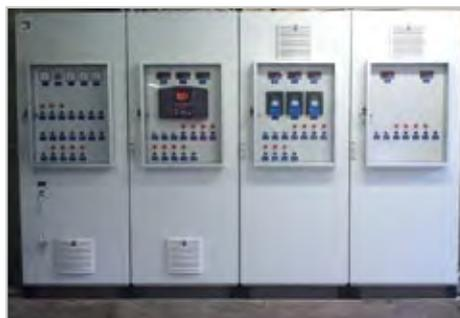
Quadro di automazione con strumentazione Dulcomarin II Disinfection Controller per misura e controllo di pH, Redox, temperatura, cloro libero e cloro totale
