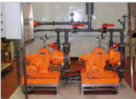
Skid di dosaggio solfato d'alluminio 6 m<sup>3</sup>/h a 6 bar
