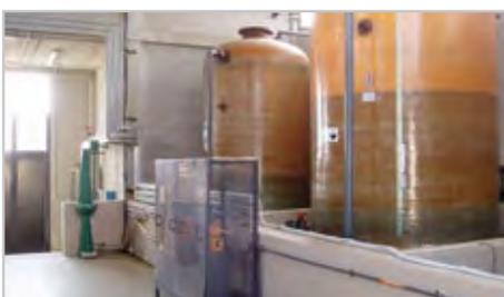
Messa in sicurezza degli stoccaggi acido 33% e clorito 25% per il generatore biossido di cloro
