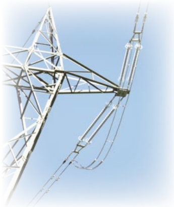
420 kV Doppel-Abspannkette
