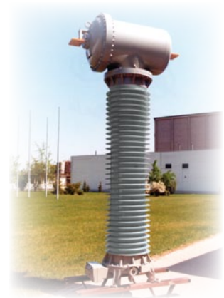
245 kV Stromwandler im Jahr 1975 installiert
