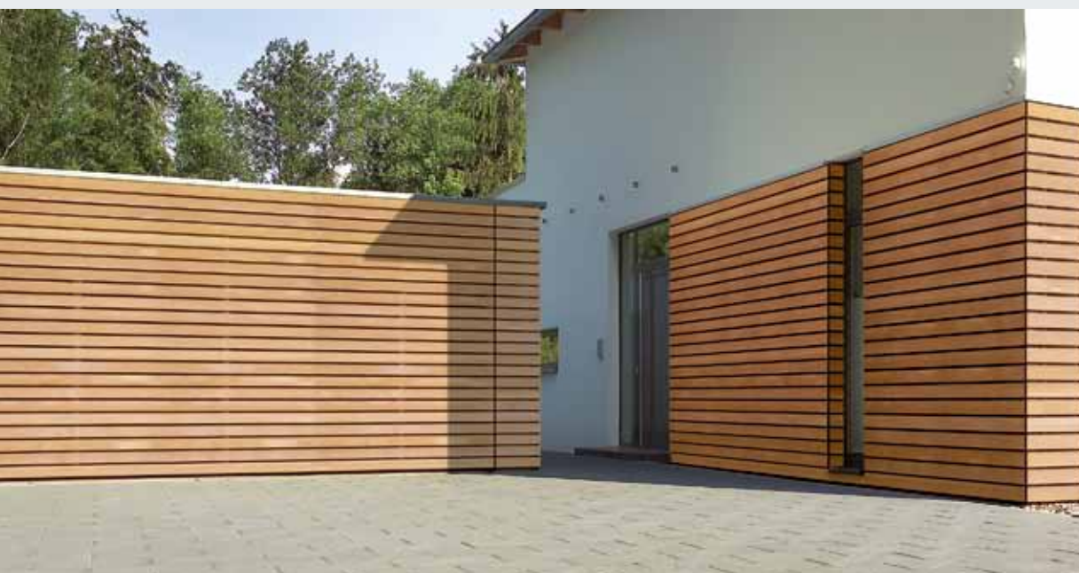
Kledning på monteringsstedet med trepaneler
