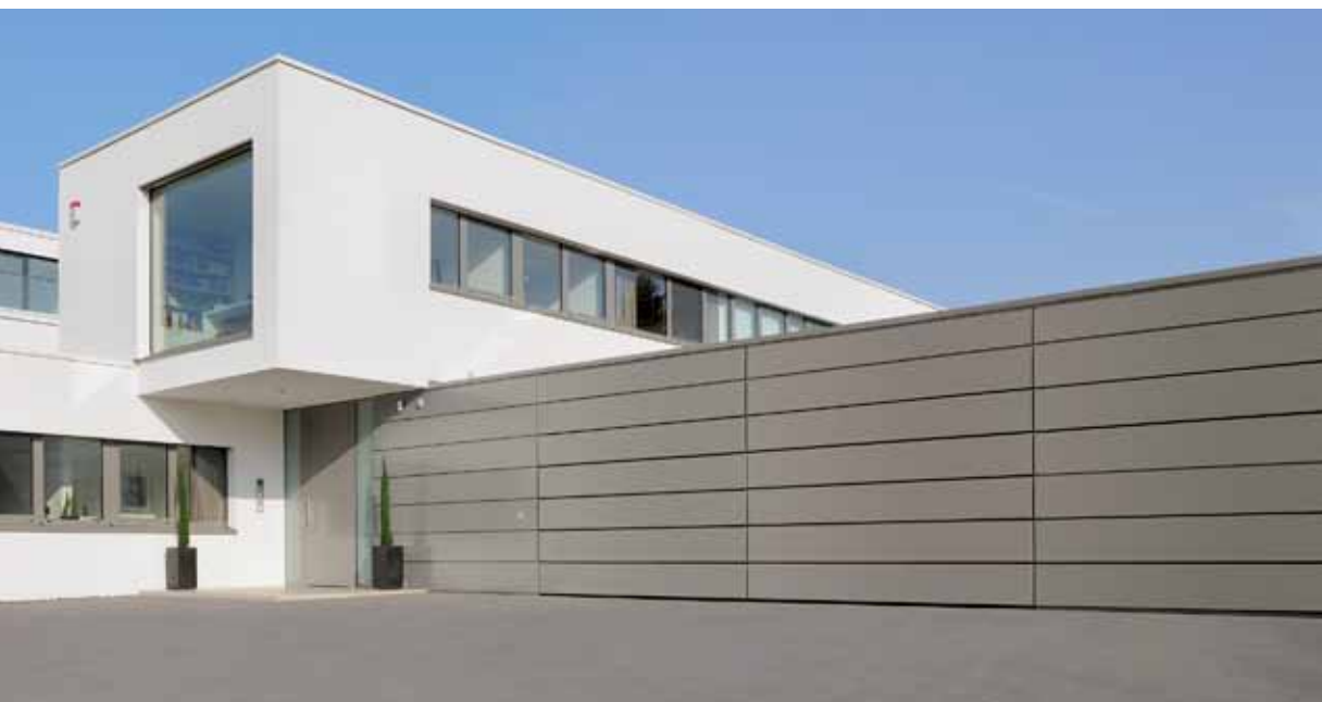
Kledning på monteringsstedet med laminerte aluminiumsplater
