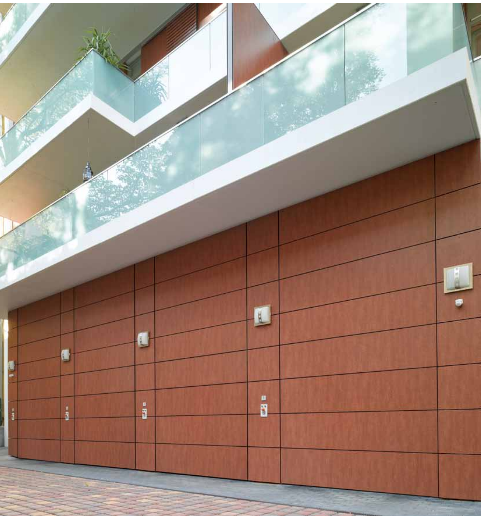
Kledning på monteringsstedet med sammenpressede laminerte treplater
