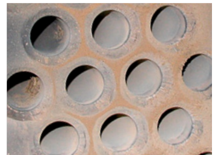
Rauchrohrkessel zur Abhitzenutzung
