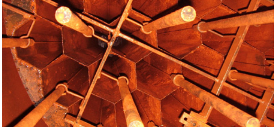
Waben eines Nasselektrofilters
