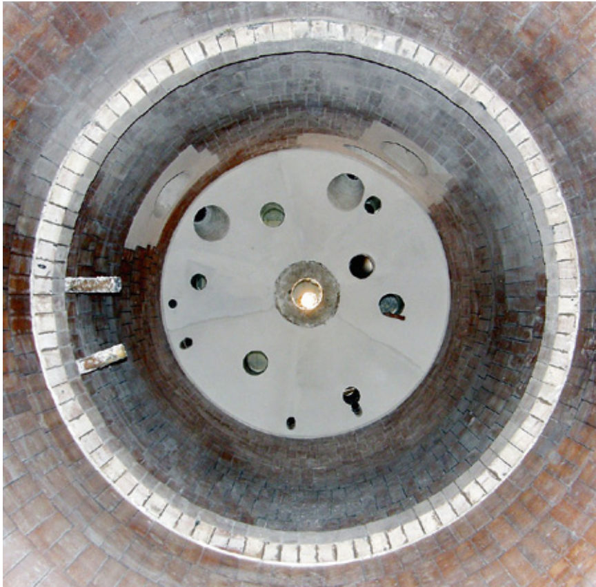
Blick in ausgemauerte Brennkammer
