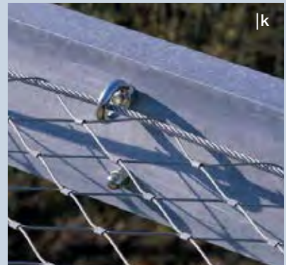
a–k Randseile und Befestigungen | Border cables and fixing points | Câbles de périphérie et fixations
