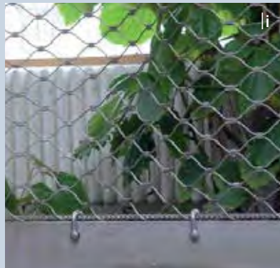
a–k Randseile und Befestigungen | Border cables and fixing points | Câbles de périphérie et fixations
