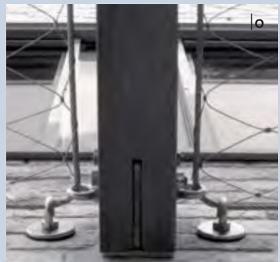
a-o Randseile und Befestigungen | Border cables and fixing points | Câbles de périphérie et fixations
