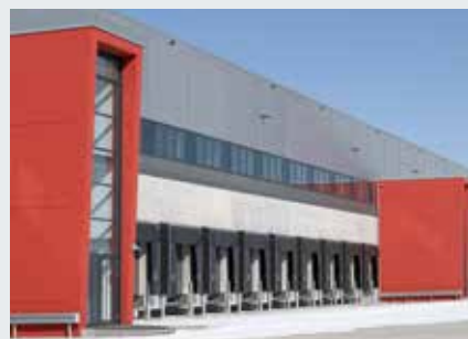
Centrum logistyczne Immogate, Monachium
