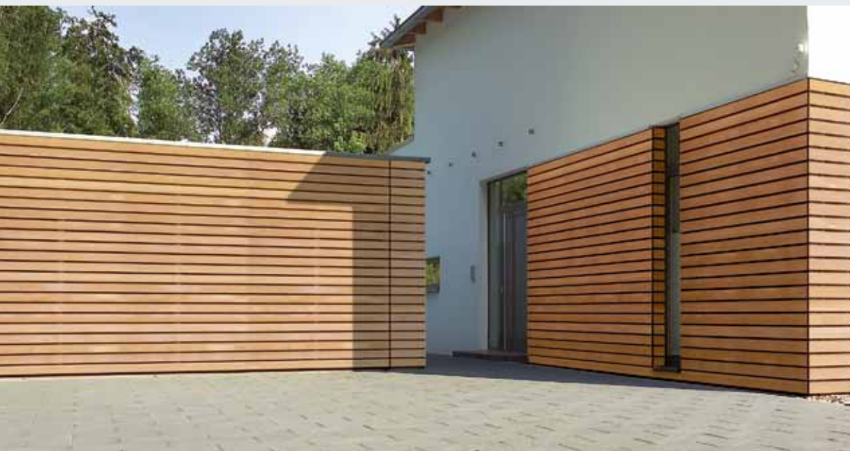
Placare la locul montării cu panouri din lemn
