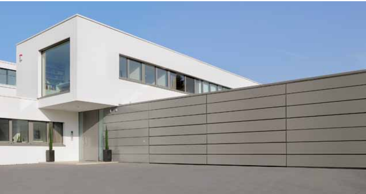
Placarea la locul montării cu panouri compozite din aluminiu
