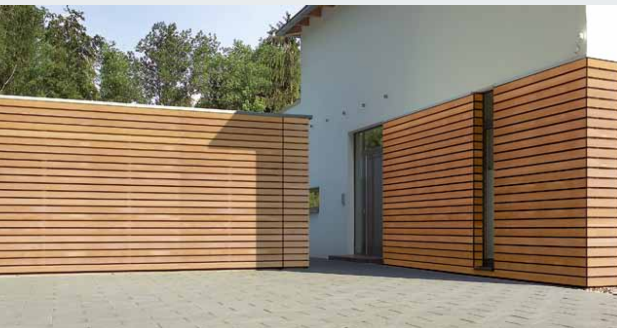
Poszycie z paneli drewnianych wykonane przez inwestora
