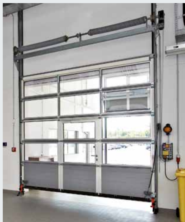
Kolorowe bramy mają od wewnętrznej strony wzmocnienia płyty** i kątowniki segmentów malowane zasadniczo w kolorze białoszarym, RAL 9002. Rama drzwi przejściowych w bramie od strony wewnętrznej jest wykonana z profili aluminiowych w kolorze E6 / C0 (poprzednio E6 / EV 1).
