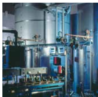
Stanowisko testowe w centrum innowacji Badger Meter
