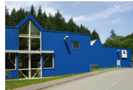
Werk 2 – Mellenbach Elektronikfertigung
