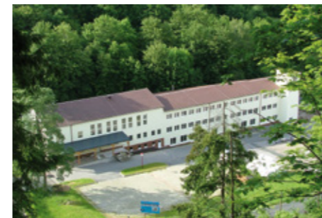
Werk 3 – Unterweißbach Transformatorenbau
