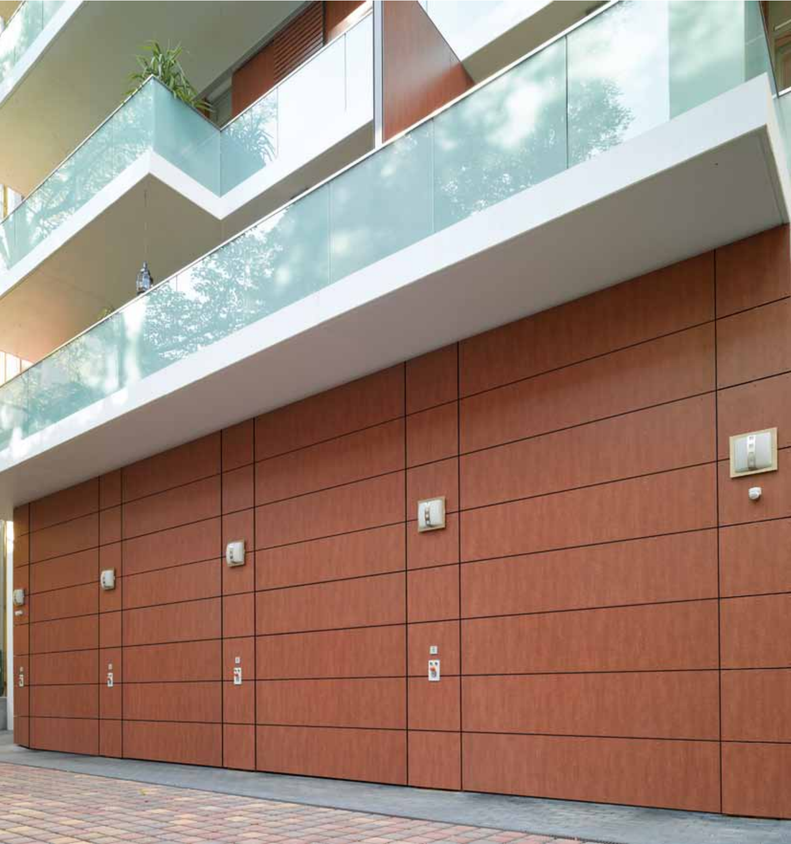
Pres ahşap plakalar ile montaj mekanında kaplama
