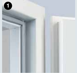
Çepçevre saran contalı köşe kasası 1,5 mm kalınlıkta
